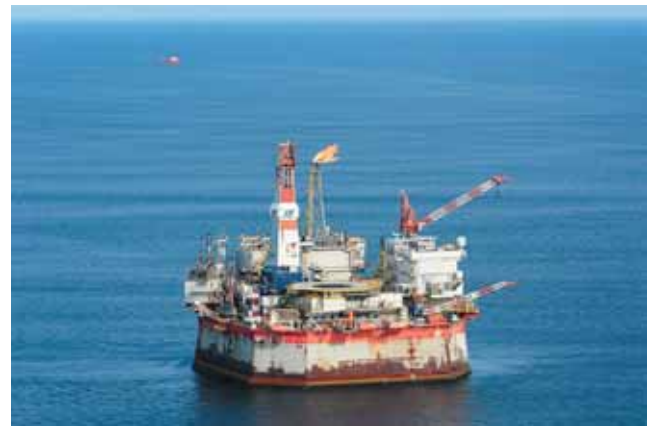
▲ Рис. 2. Морская стационарная нефтедобывающая платформа ПА-А ▲ Fig. 2. Offshore stationary oil production platform PA-A
